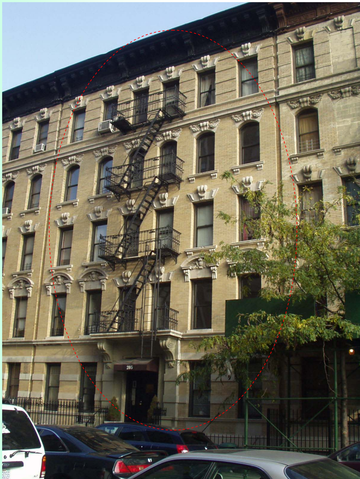
物件全景(地下1階、地上5階)
